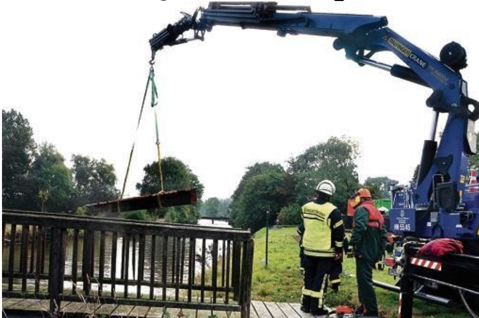
Stück für Stück wird die Brücke über die Ollen bei Hekeln abgebaut: Feuerwehrleute und Mitarbeiter des Technischen Hilfswerkes trainieren ihre Zusammenarbeit nach einem angenommenen Unglücksfall in der Gemeinde Berne. Bild: Gabriele Bode
