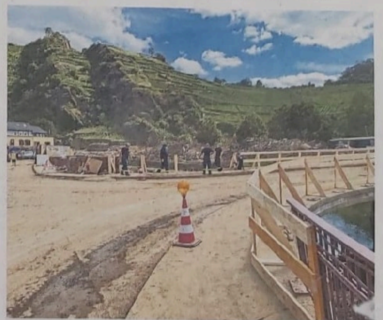
Das THW hat dafür gesorgt, dass die einzige Brücke über die Ahr, die in Mayschoß nicht weggespült wurde, nun wieder benutzbar ist und ein Geländer hat.
